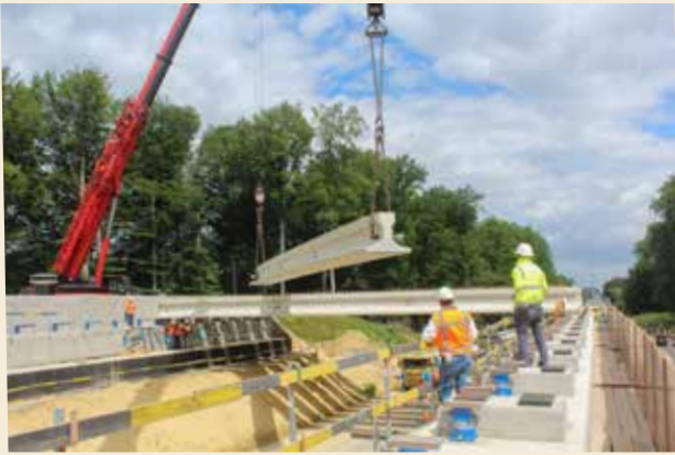
Installation des poutres porteuses (©Life+OZON)
